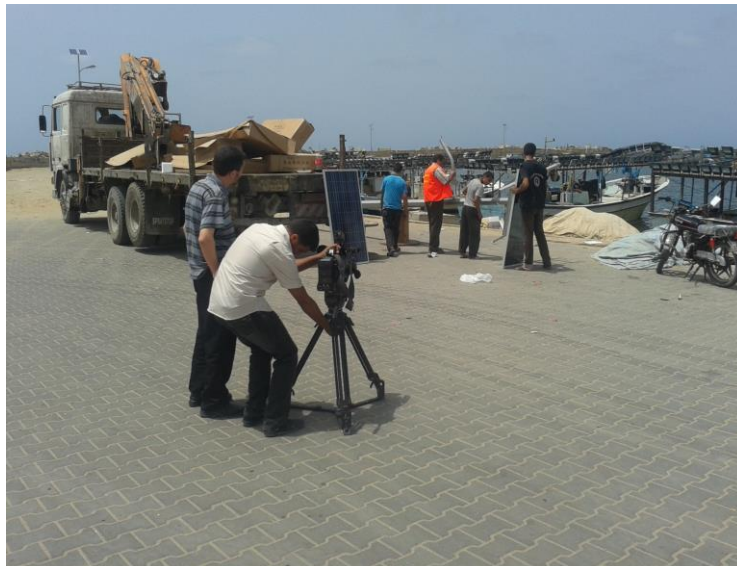
Avvio del cantiere - Maggio 2013
