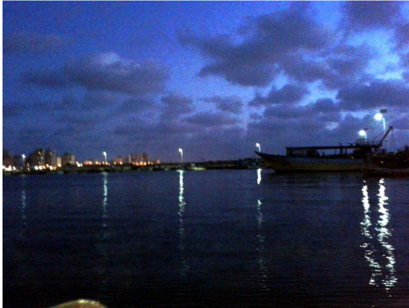
I primi 6 lampioni installati dei 16 complessivi
